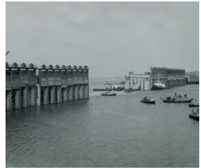
Bouw van de Veerse Gatdam, foto: https://beeldbank.rws.nl , Rijkswaterstaat
