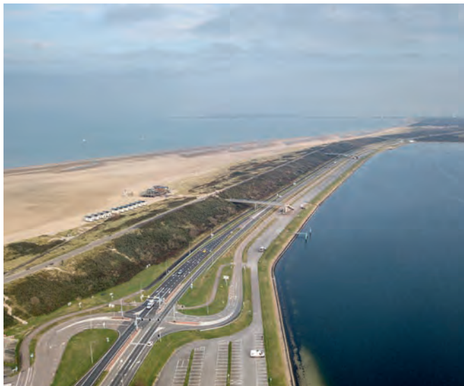
De Veerse Gatdam heeft twee gezichten. Een natuurlijke uitstraling aan de zeezijde en een civieltechnische uitstraling aan de meerzijde
